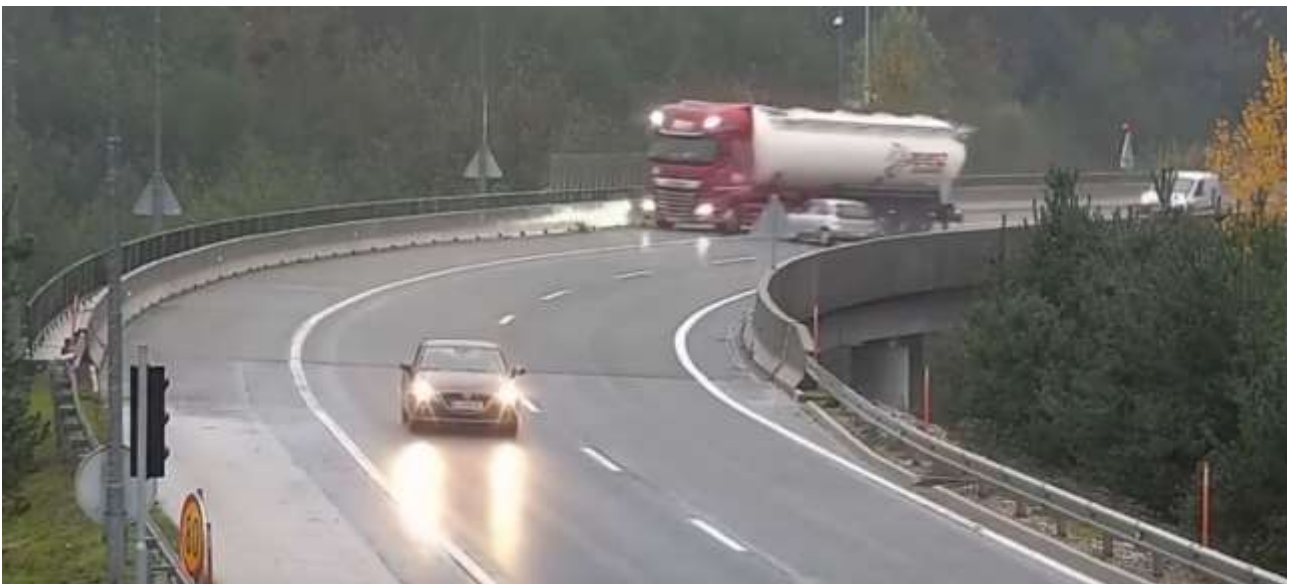
Рис. 1. Приклад дорожньо-транспортної пригоди, викликаній недостатнім поперечним нахилом віража на ділянці автомобільної дороги зі значним нахилом осі поздовжнього профілю
