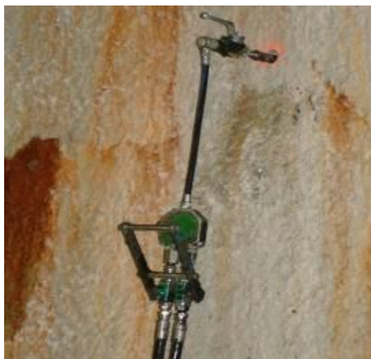
Рис. 1 - Підключення двокомпонентного насосу до пакеру.
