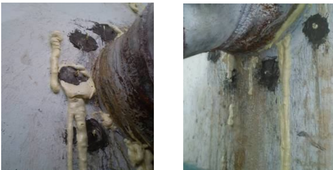
Рис. 2 - Вихід піни в місцях вводу інженерних комунікацій після ін'єктування.
