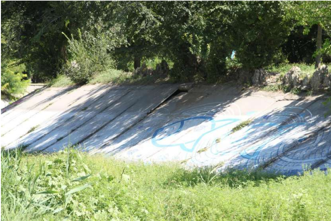
Рис. 2. Під окремими плитами є повітряний проміжок, не забезпечена «постіль» для їх обпирання
