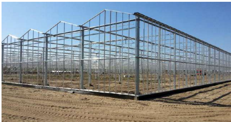
Рис. 1 - Металевий каркас теплиці
