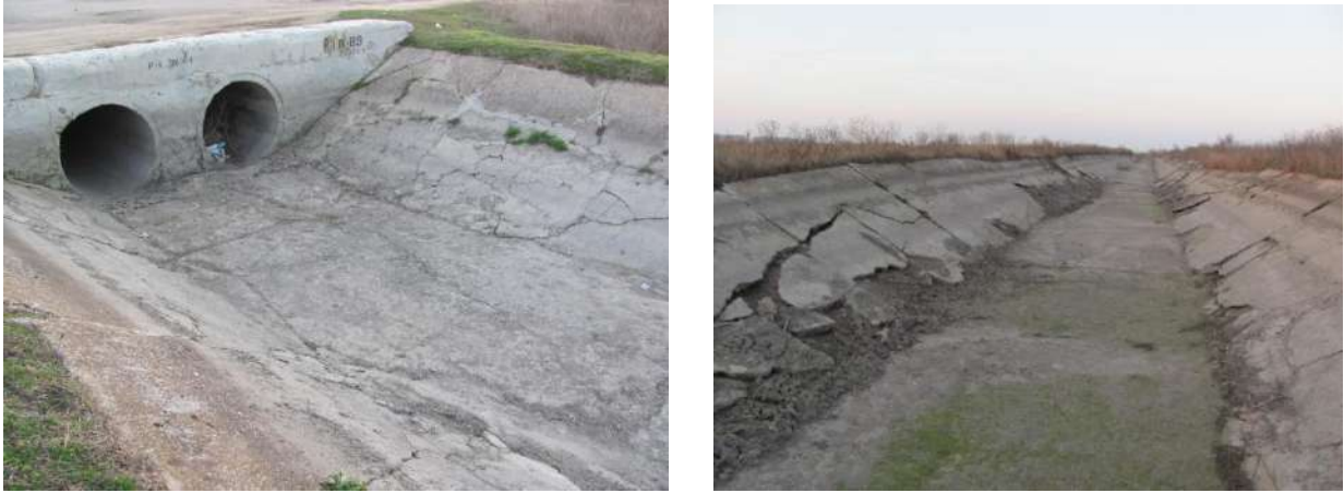
Рис. 1.2 – Стан облицювання каналу Р-1 ПК40-ПК41
