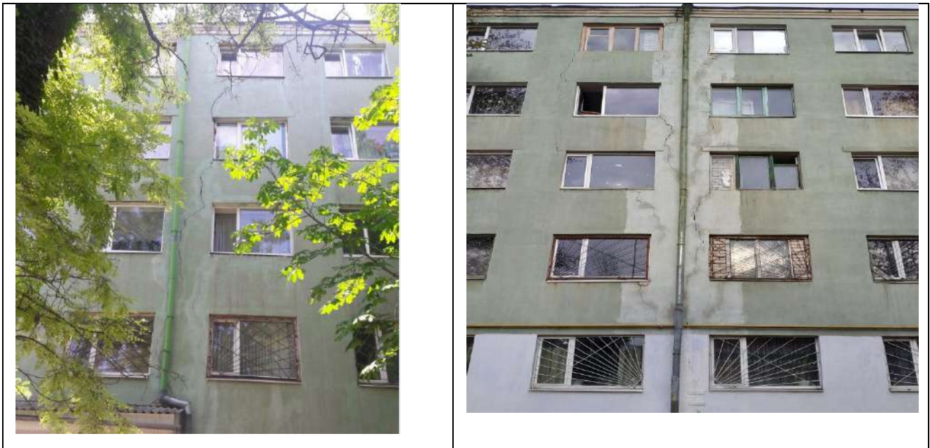
Рисунок 2 – Тріщина на фасадах будівлі: – а) на головному, 13.02.2018р. – б) на дворовому, 27.11.2018р.
