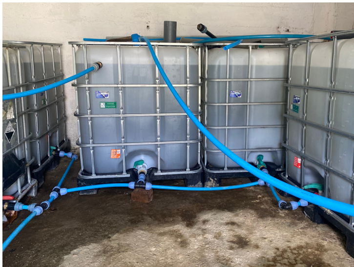
Система збору дощової води в екоцентрі “Тепла гора” (с. Черетів, Івано-Франківська область)
