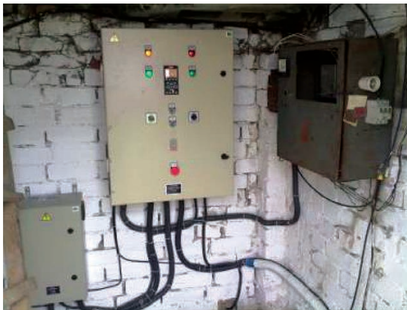
Рис. 2. Блок управління режимом роботи насосного агрегата свердловини № 2-25
