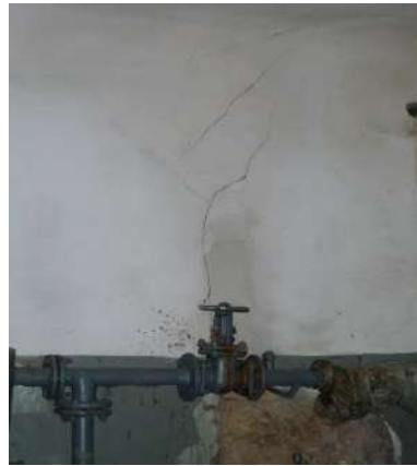
Рис. 8. Сліди замокання на зовнішніх стінах
