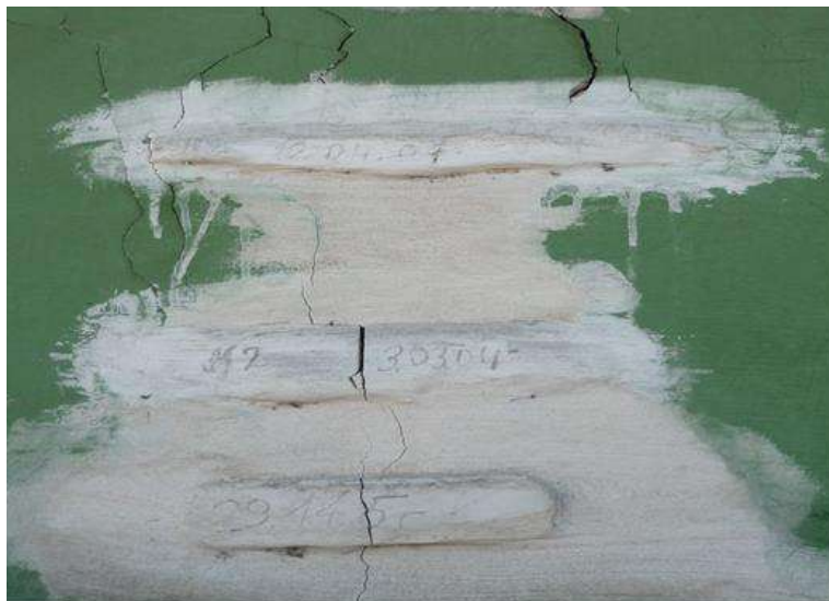
Рис. 2. Маяки, встановлені при попередніх оглядах
