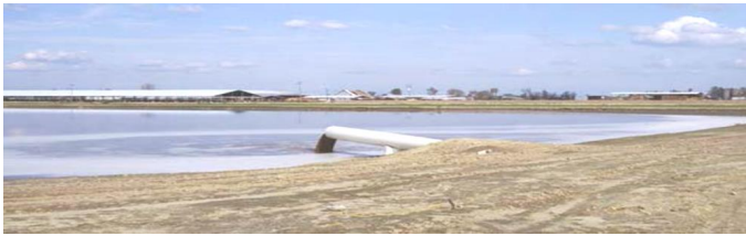
Рис. 1. Лагуна відкритого типу для зберігання відходів тваринництва
