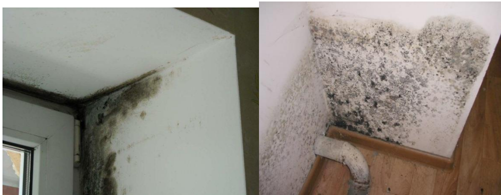
Рис. 2. Плесневые грибки на поверхности ГКЛ
