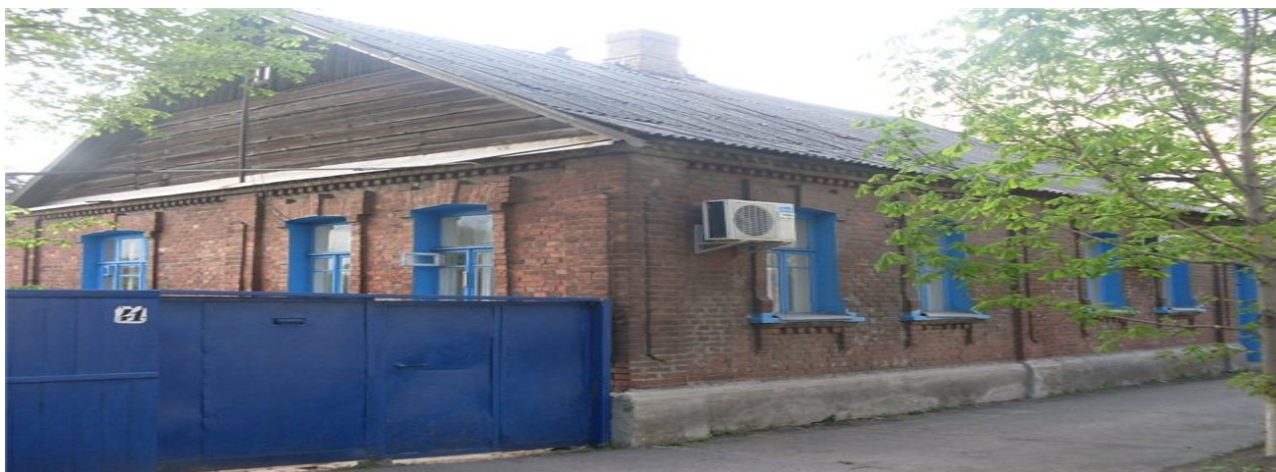
Дом по ул. Розы Люксембург (ул. Почтовая)
