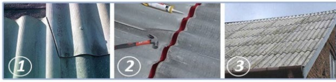
Рис. 4. Укладка хризотилцементных листов без смещения рядов
