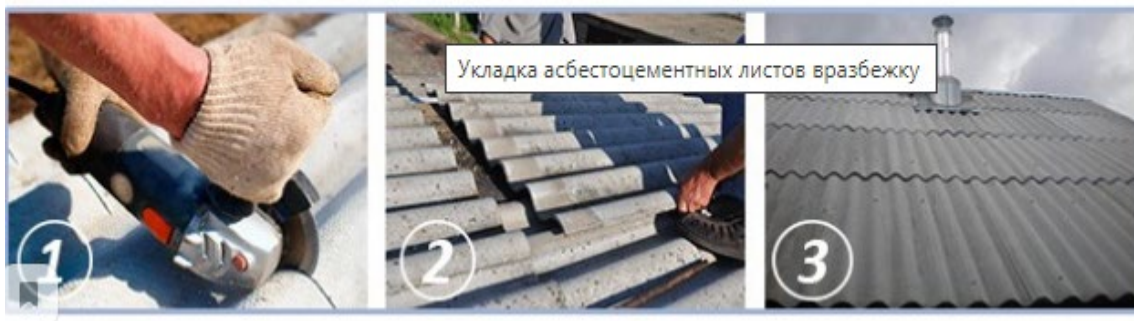
Рис. 3. Укладка хризотилцементных листов вразбежку
