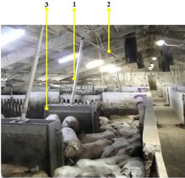
Рис. 3 Система подачі сухого корму на відгодівлі 1 – опуск, 2 – ланцюгово-шайбовий транспортер, 3 – кормовий автомат
