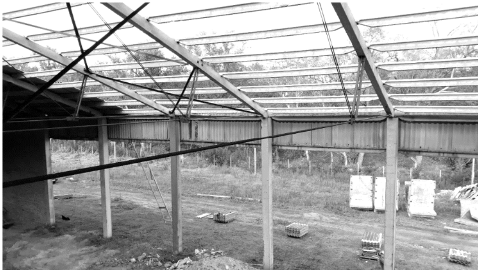
Фото 1. Загальний вигляд несучих конструкцій покрівлі
