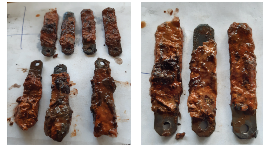
Рис. 2. Зовнішній вигляд зразків після витримки в напірному трубопроводі НС-2.
