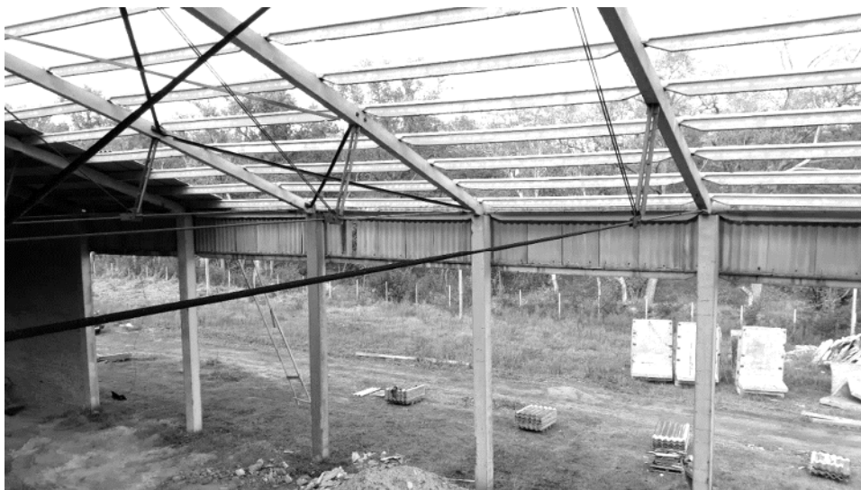
Фото 1. Загальний вигляд несучих конструкцій покрівлі
