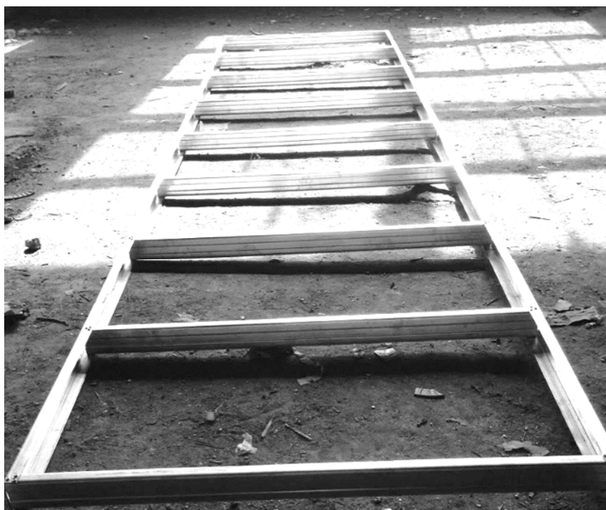
Фото 2. Загальний вигляд рами Р1 в зборці
