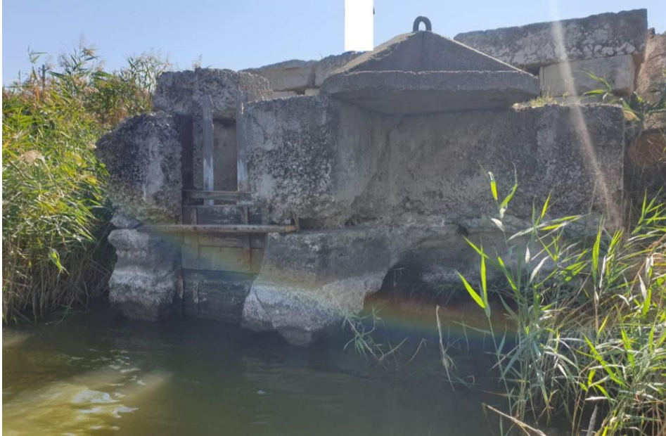
Рис. 1. Загальний вигляд гідротехнічної споруди
