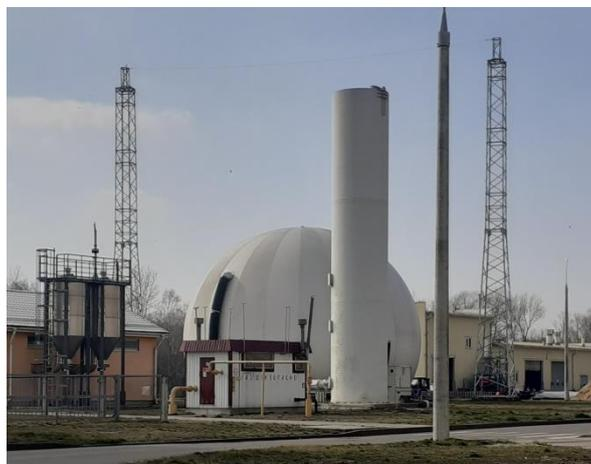
Рисунок 2 – Газгольдер – резервуар для накопления биогаза и выравнивания потока перед подачей на мини-ТЭЦ
