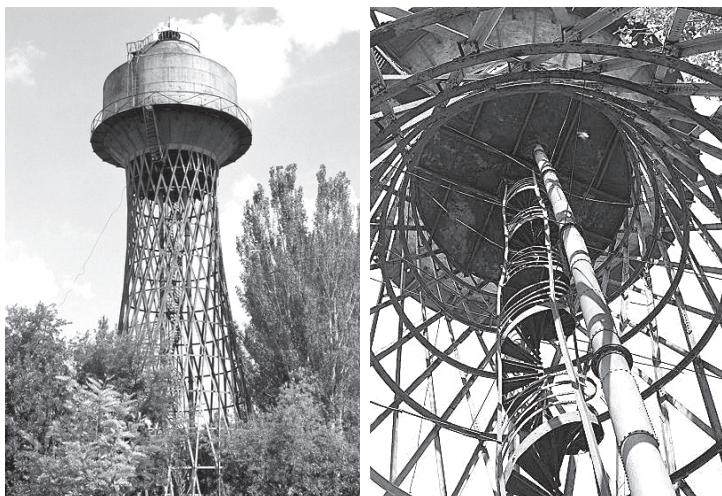
Рис. 6.12. Водонапірна вежа і її міцний каркас
