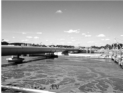
Рис. 6.19. Робота активного мулу на стадії біологічного очищення
