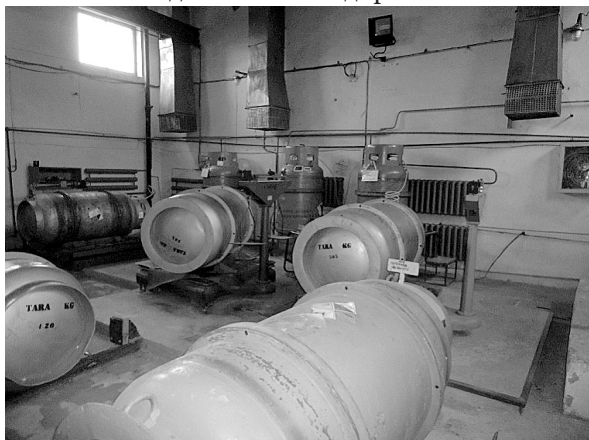
Рис. 6.16. Ежекторна, де відбувається процес хлорування води
