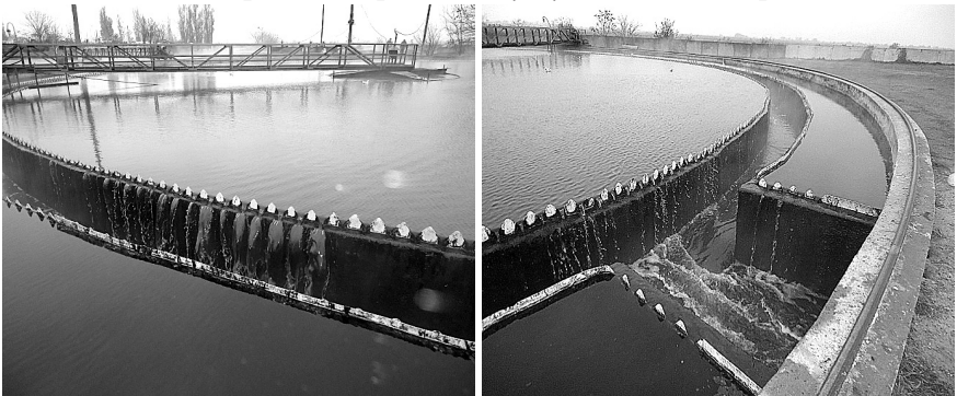
Рис. 10.11. Периферійний лоток одного з вторинних відстійників.
