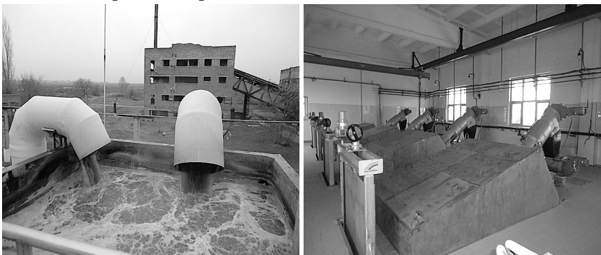
Рис. 10.4. Приймальна камера.
