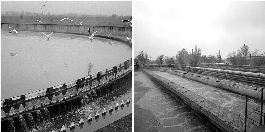
Рис. 10.7. Первинний кільцевий лоток та коридорні аеротенки.
