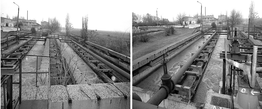
Рис. 10.9. Рух муловодяної суміші уздовж коридорів аеротенків.
