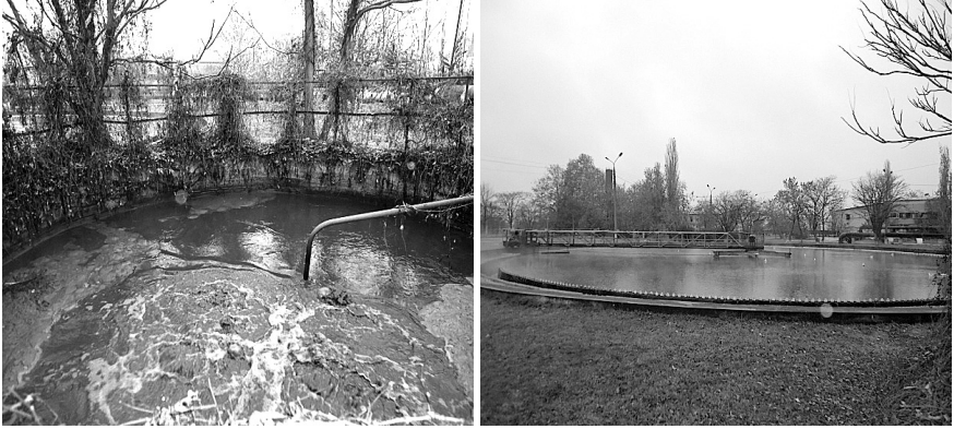
Рис. 10.10. Вторинні відстійники для осадження активного мулу.
