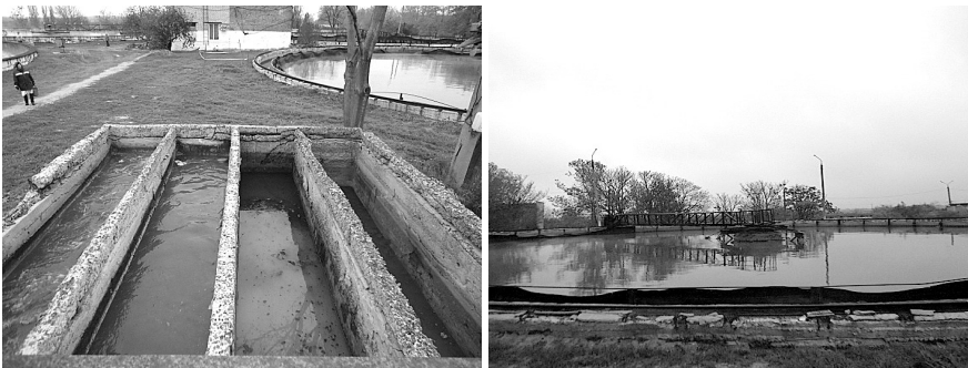
Рис. 10.6. Преаератори та первинні радіальні відстійники.
