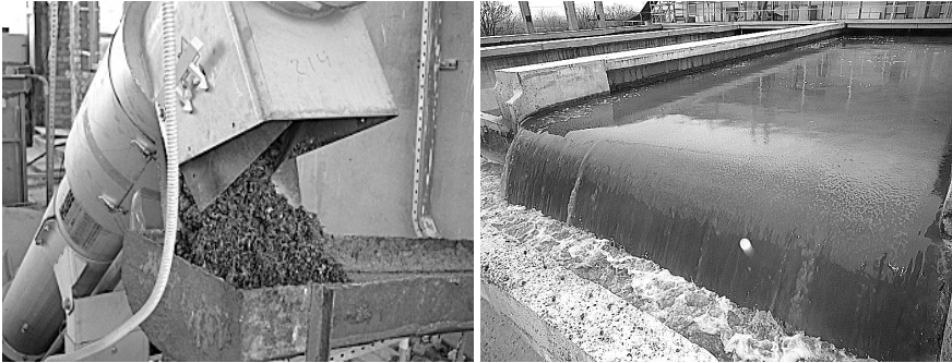
Рис. 10.5. Механічні граблі скидають відходи на пересувний пристрій, звідки їх видаляють на мулові поля.
