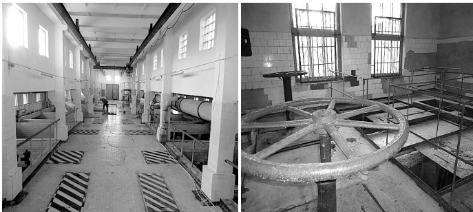
Рис. 6.15. Камери сіток, де відбувається фільтрація – перший етап водопідготовки води
