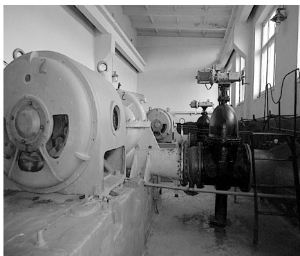
Рис. 6.17. Технічне обладнання для додавання коагулянтів
