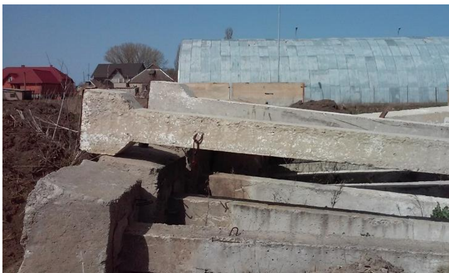
Фото 2. Залізобетонна двоконсольна колонна з фундаментом
