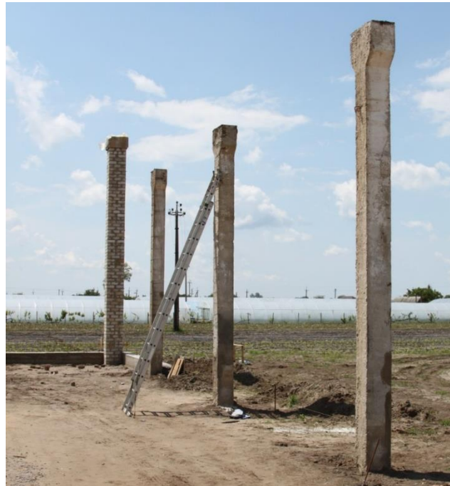
Фото 3. Загальний вигляд збірних залізобетонних колон №1-3.
