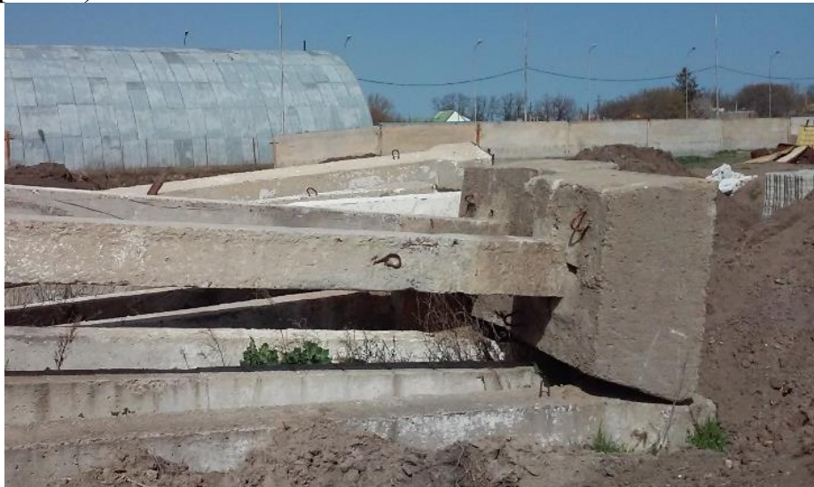
Фото 1. Загальний вигляд фундаменту
