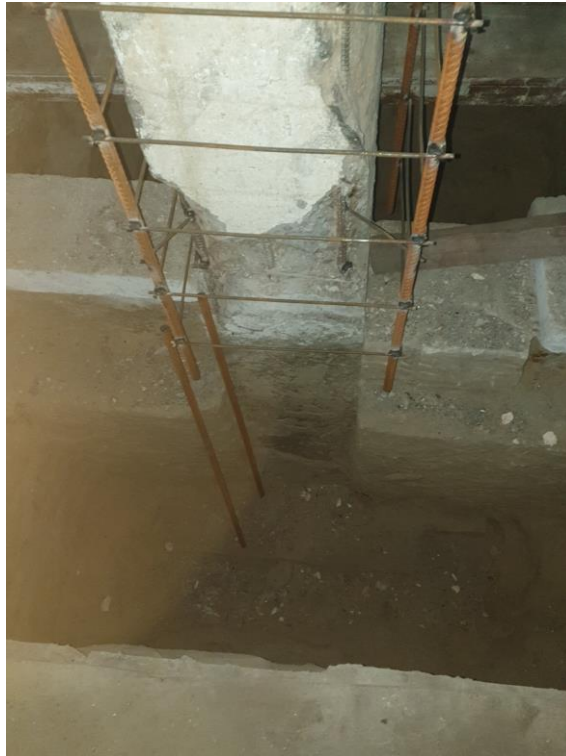
Рис. 3. Відновлення колони на рівні фундаменту
