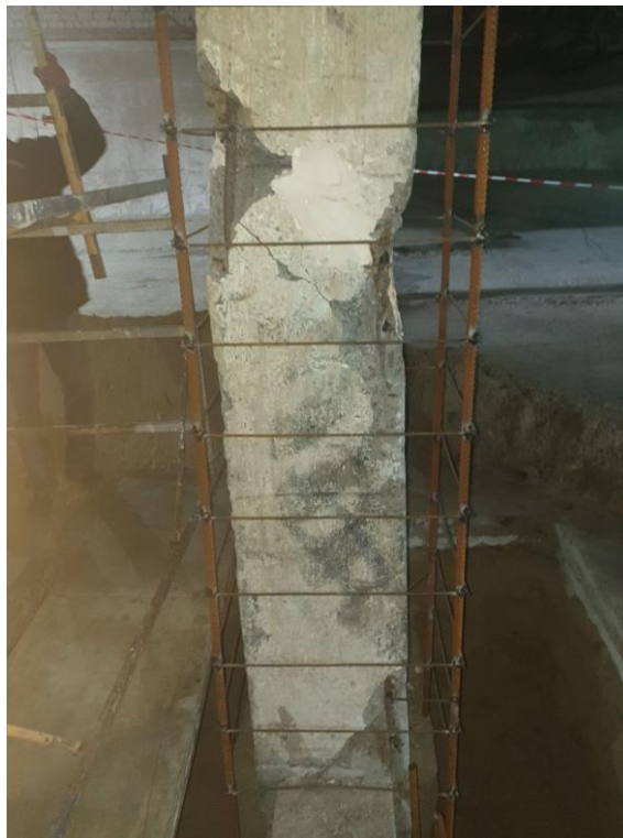
Рис. 2. Встановлення підготовленого каркасу
