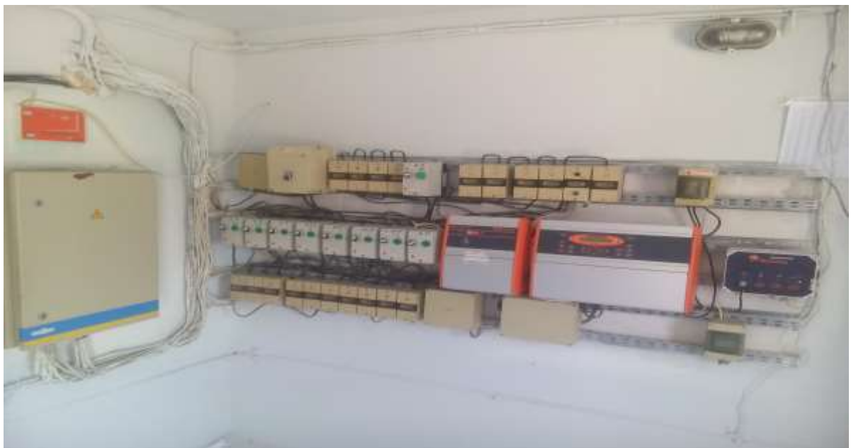
Рис. 3.2 Контрольована система мікроклімату Big Dutchman
