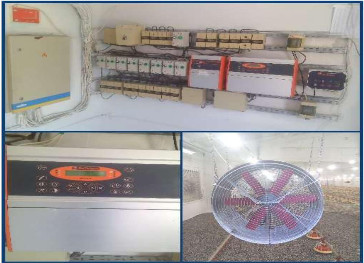
Апаратна контроль за мікрокліматом та вентиляцією
