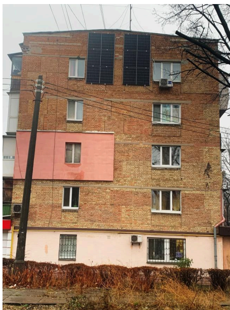
Рис. 1 Сонячні панелі на фасаді будинку
