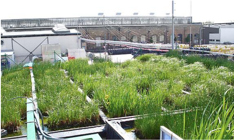
Рис. 1. Станція очищення стічних вод на даху компанії John Deere у Мангеймі
