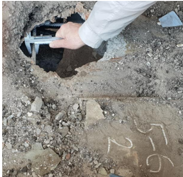
Рисунок 3 – Вхідний отвір у плитній частині прогонових будов моста
