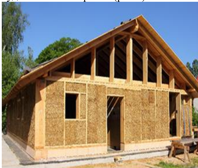
Рис. 1. Зведена будівля із пресованої соломи
