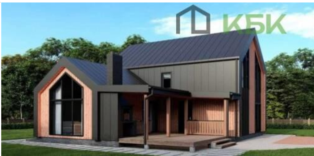
Рисунок 2 – Дерев'яний каркасний будинок, побудований компанією «КБК»
