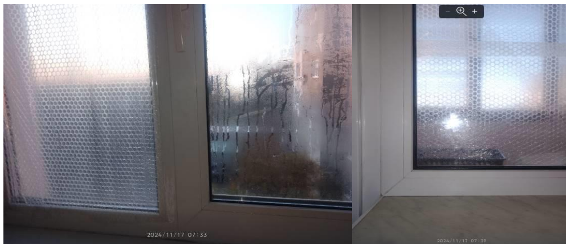
Рис. 6. Приклад результату від утеплення пароізоляції склопакетів вікон
