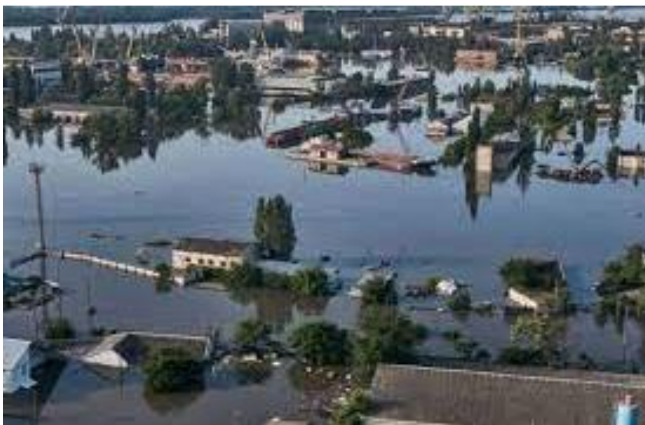
Рис. 2. Затоплення території Херсонської області після руйнування Каховської ГЕС
