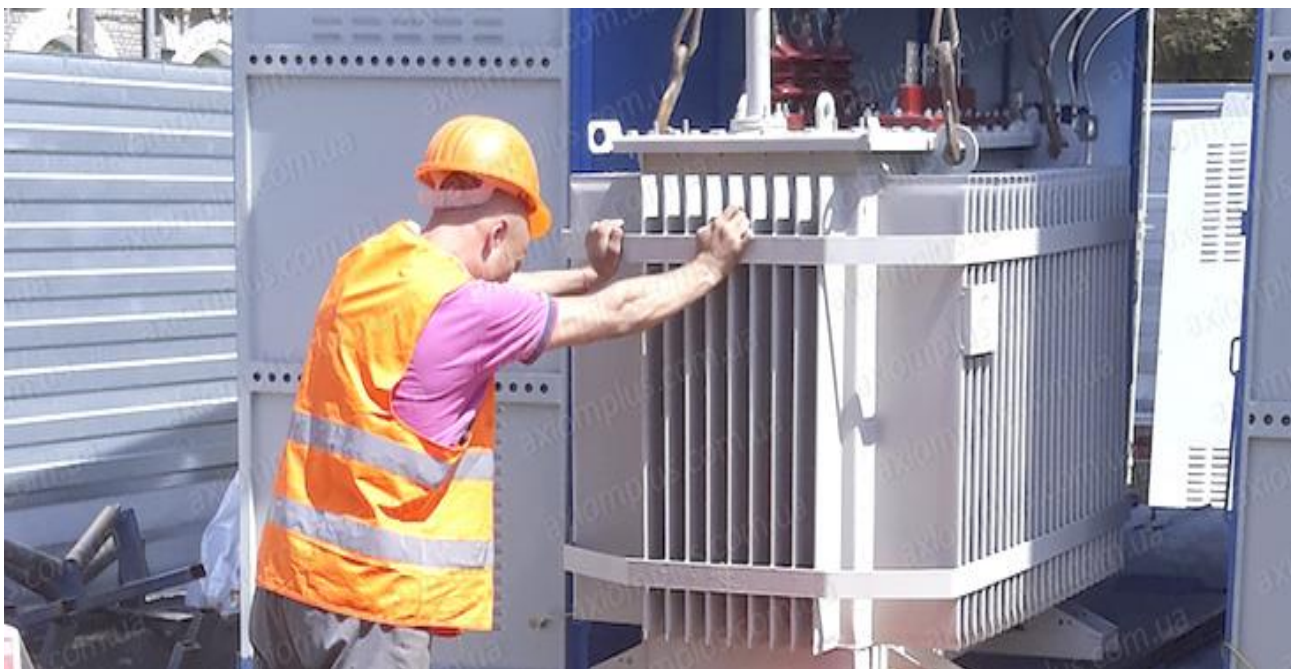
Рис.2. Установка ТП на бетонний фундамент за допомогою автомобільного крана
