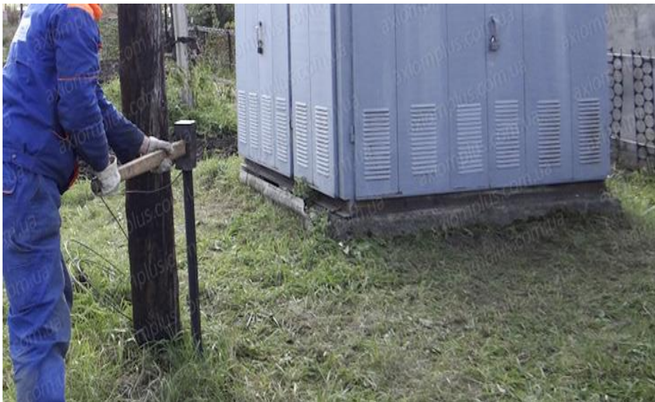
Рис.3. Установка заземлюючого пристрою до ТП
